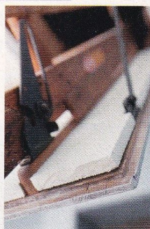
Sogar die Treppe zum Dachgeschoss bekam eine Dämmung
